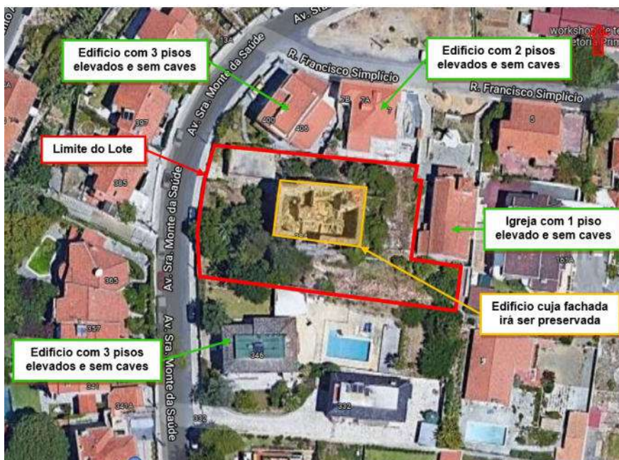
Figura 2 – Vista aérea do recinto de escavação
