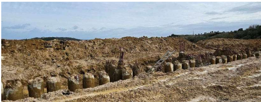
Figura 12 - Cortina de estacas parcialmente executada.
