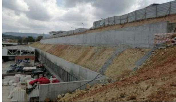
Figura 5 – Vista da execução da contenção periférica ao abrigo de uma cortina de estacas com o segundo nível de travamento já executado assim como o betão projetado entre estacas
