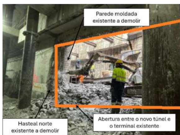
Figura 4 - Vista de uma abertura no Hasteal e Parede Moldada existente, a partir do interior da Estação Terminal
