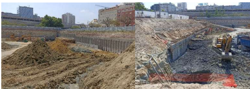
Figura 20 - Trabalhos de escavação geral no interior da parede de contenção
