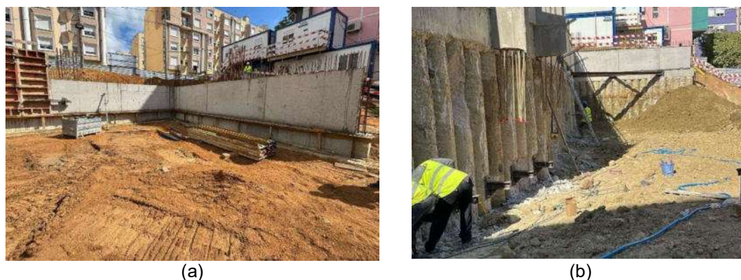
Figura 6 – Execução da cortina de estacas: (a) muro tradicional sobre a viga de coroamento; (b) viga de distribuição metálica e escoramentos metálicos de canto
