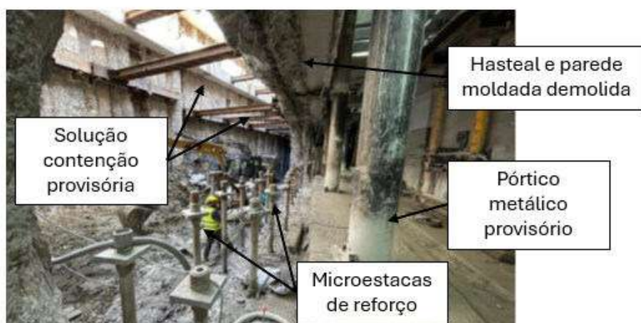
Figura 11 - Vista dos tubos das Microestacas sobre o alinhamento dos Pilares e Viga-Parede
