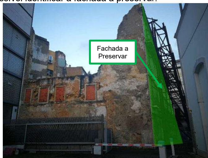
Figura 2 - Fachada a preservar (imagem fotografada no local).
