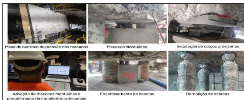
Figura 22. Procedimento de transferência de cargas e início da demolição das estacas
