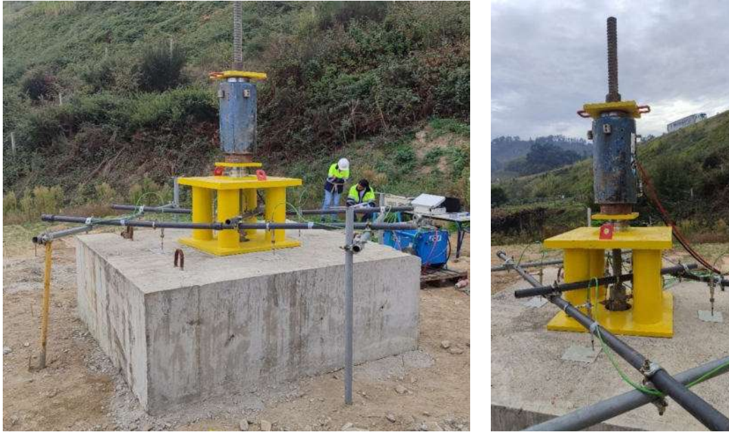
Figura 5 – Sistema de reação da prova de carga
