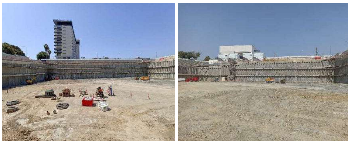
Figura 9 – Vista da obra em fase final dos trabalhos de escavação.
