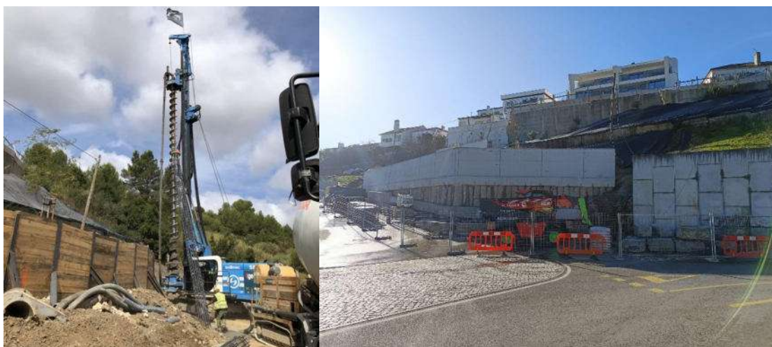
Figura 8 – Início dos trabalhos de estabilização (a esquerda) e fim dos trabalhos de estabilização (a direita).
