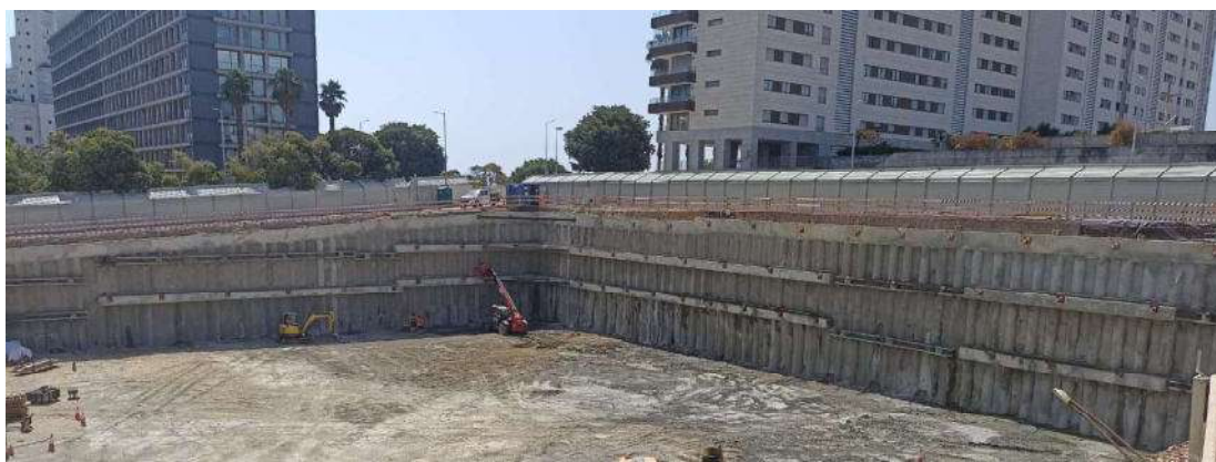
Figura 2 – Desenvolvimento do coroamento da cortina.
