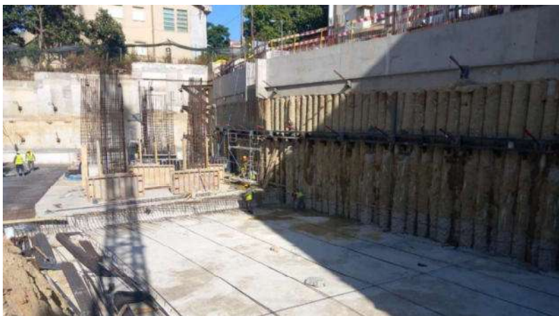
Figura 7 – Solução final adotada após escavação da altura total definida em projeto (“Berlim Definitivo” e Cortina de Estacas)
