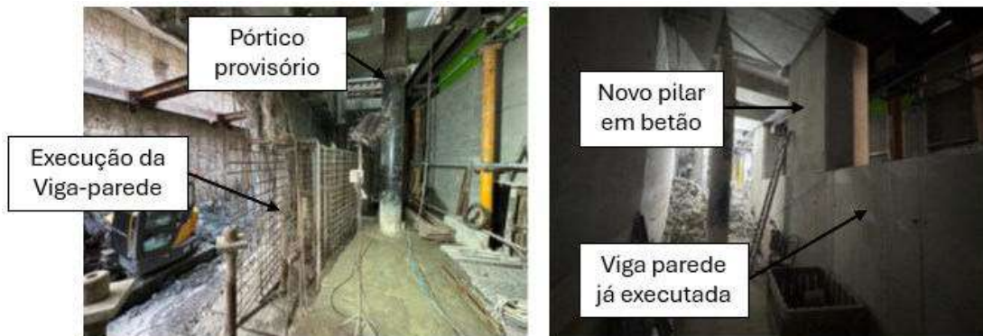
Figura 13 - Vista da nova Viga de Parede apoiada em Microestacas (à esquerda) e vista da nova Viga de Parede, Pilares (à direita).
