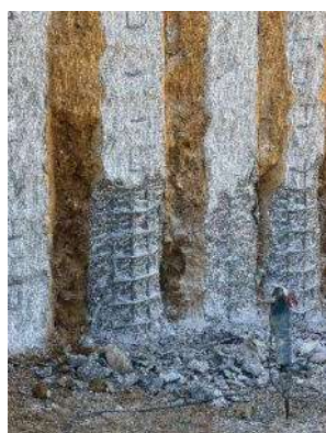
Figura 15 -Preparação para execução da viga de distribuição.
