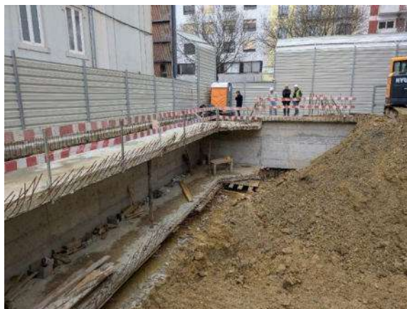
Figura 4 – Execução in situ da Contenção ao Nível do Piso -1
