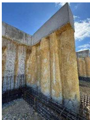
Figura 16 – Montagem de armaduras da viga de distribuição.
