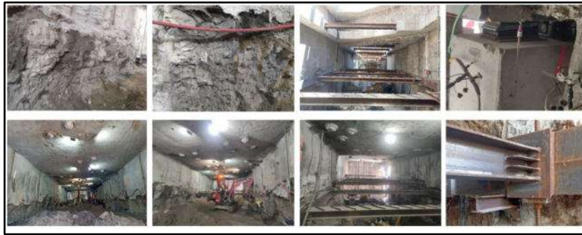
Figura 24. Obra em fase de fundo de escavação.
