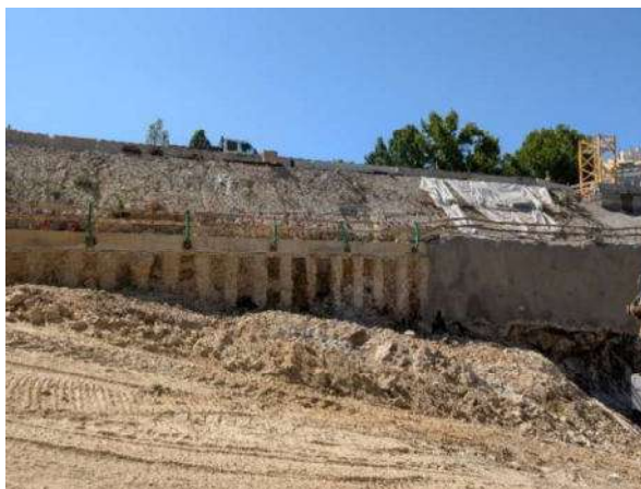
Figura 6 – Solução de cortina de estacas.
