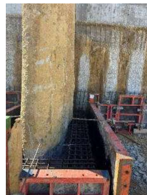
Figura 17 – Preparação da cofragem para betonagem da viga de distribuição.
