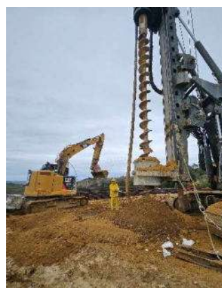
Figura 14 – Execução das estacas.
