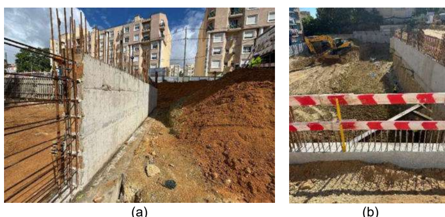
Figura 4 – Cortina de estacas em fase de execução da obra: (a) pormenor da execução do muro; (b) aterro a tardoz do muro realizado e início da escavação
