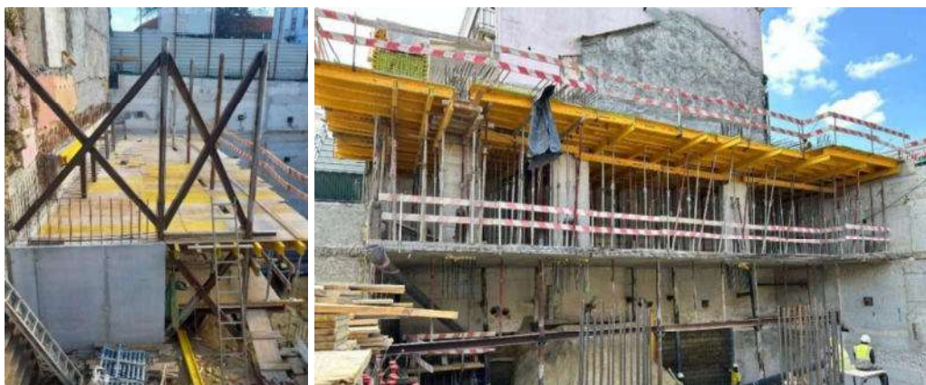
Figura 7 – (a) Treliça provisória de apoio às bandas de laje e respectivo muro, e banda de laje, numa fase intermédia de execução
