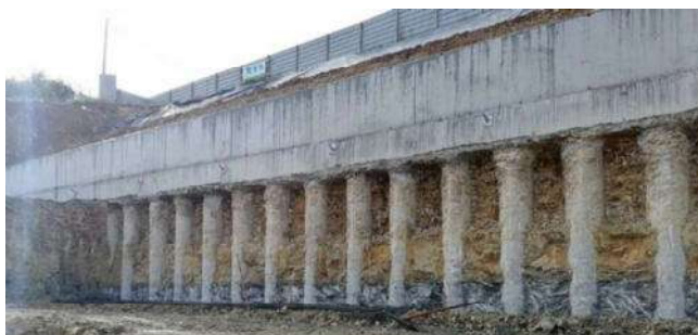
Figura 3 – Vista da execução da contenção periférica ao abrigo de uma cortina de estacas com o primeiro nível de travamento já executado ao nível da viga de coroamento
