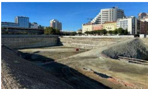
Figura 21 - Vista da obra em fase final de escavação: Cortina de estacas da Parcela A (esquerda) e parede moldada do Lote B1 (direita), ambas travadas por ancoragens
