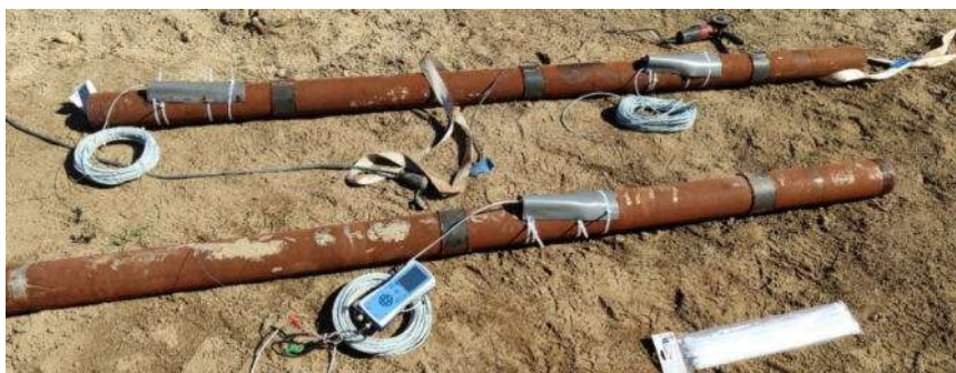
Figura 3 – Instalação da instrumentação
