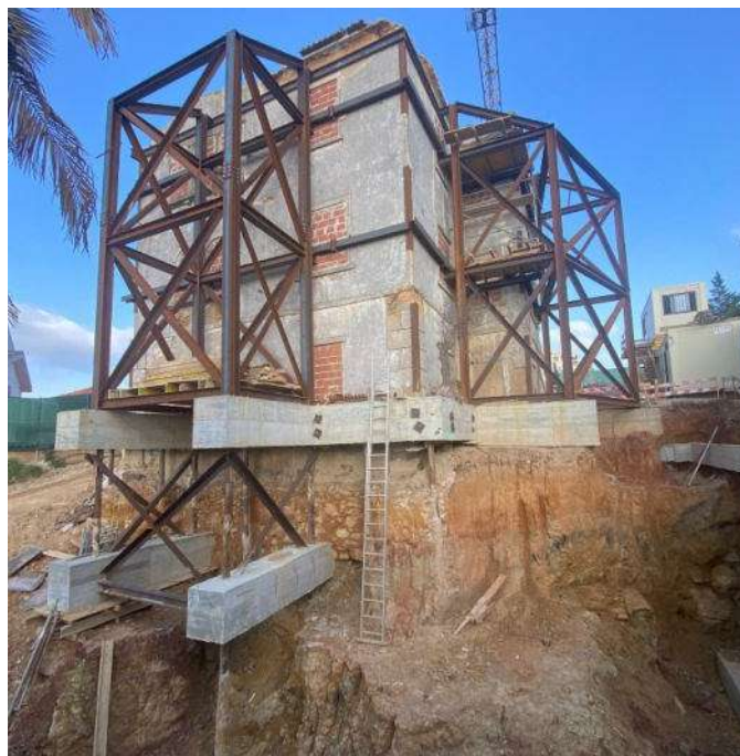
Figura 4 – Estruturas de contenção e recalçamento das fachadas existentes
