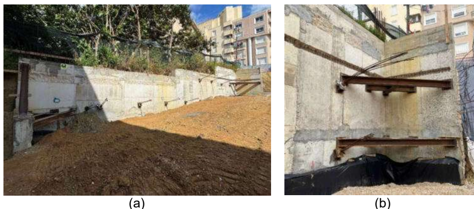
Figura 3 – Parede de contenção do tipo “Berlim Definitivo” em obra: (a) vista geral da solução; (b) pormenor de travamento horizontal provisório – escoras de canto e ancoragens
