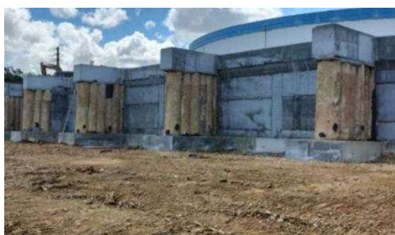
Figura 11 - Fotografia da cortina de estacas com contrafortes, executada.
