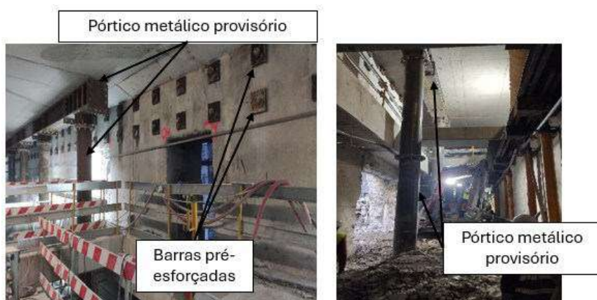
Figura 10 - Vista de uma das aberturas, das Barras Pré-Esforçadas (Primeira Fase) e do Pórtico Metálico Provisório (Segunda Fase)
