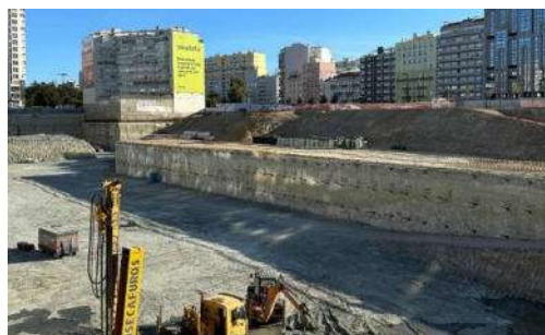
Figura 21 - Vista da obra em fase final de escavação: Cortina de estacas da Parcela A (esquerda) e parede moldada do Lote B1 (direita), ambas travadas por ancoragens
