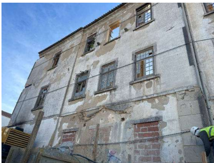
Figura 3 – Trabalhos prévios de estabilização e confinamento das fachadas
