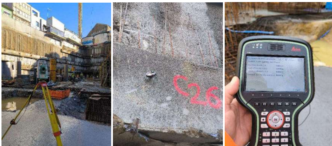
Figura 6 - Imagens do Sistema de Monitorização instalado no Fundo de Escavação
