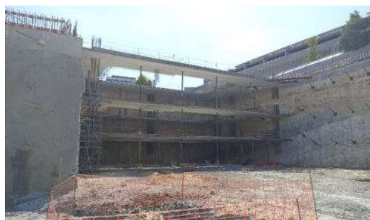
Figura 22 - Fase final de escavação: Parede moldada da Parcela A travada por bandas de laje
