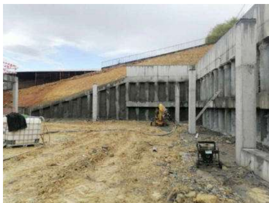
Figura 4 – Vista da execução da contenção periférica ao abrigo de uma cortina de estacas com o segundo nível de travamento já executado assim como o betão projetado entre estacas
