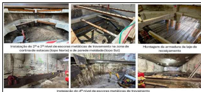
Figura 23. Trabalhos de escavação e instalação das escoras metálicas de travamento.
