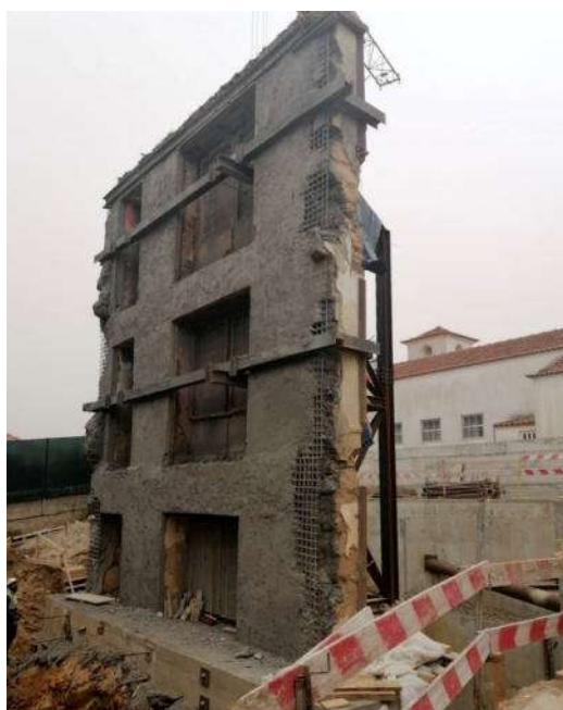
Figura 5 – Reforço das paredes de alvenaria de pedra com malha de armadura e betão projetado
