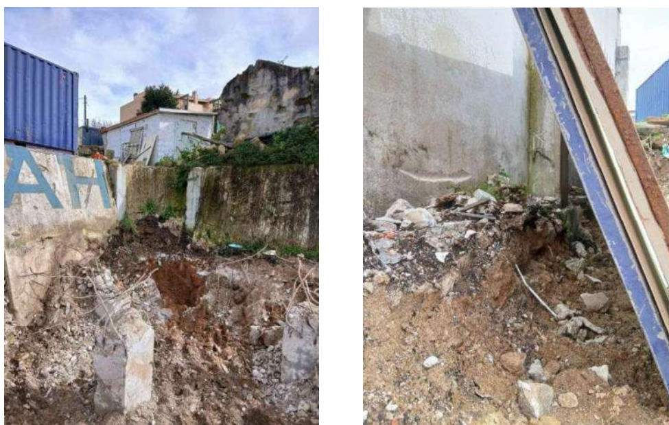
Figura 2 - Estruturas Existentes a demolir no interior do lote
