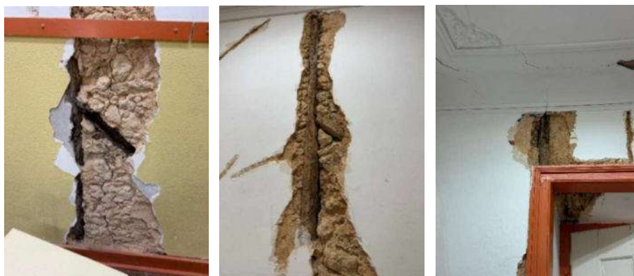
Figura 2 - Constituição estrutural das paredes do edifício vizinho
