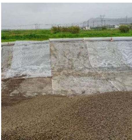
Figura 10 - Colocação dos agregados leves sobre geocompósito.
