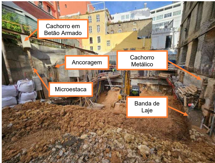
Figura 7 - Foto capturada no decorrer dos trabalhos em obra, com a identificação dos elementos mais relevantes
