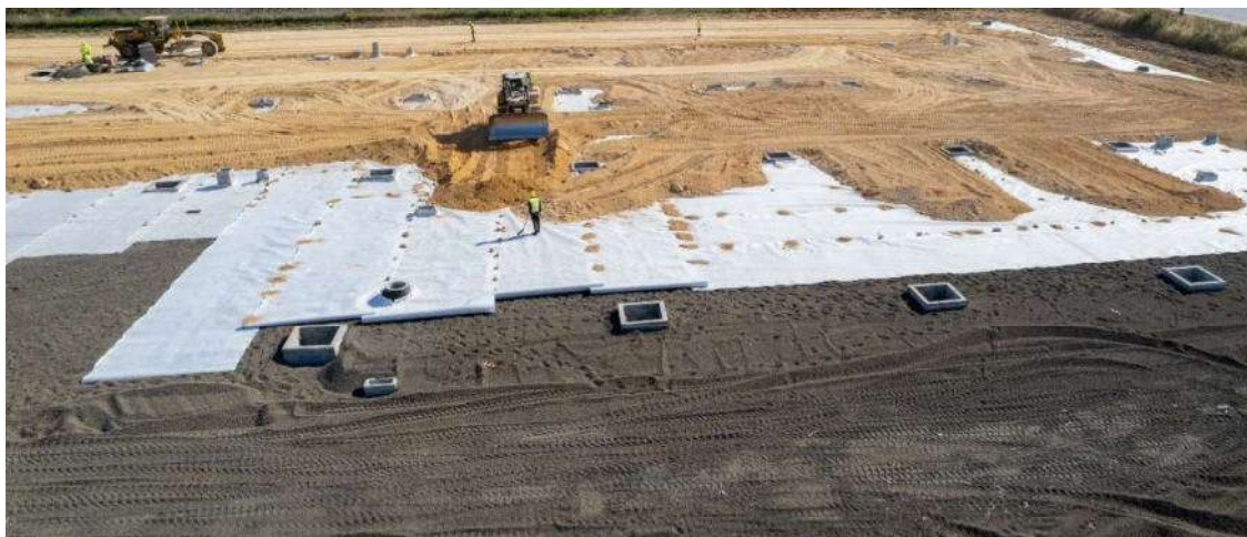
Figura 12 - Colocação da geogrelha com geotêxtil sobre os agregados leves e aplicação de camada de ABGE.
