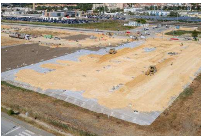
Figura 11 – Vista global da colocação da camada de ABGE sobre o aterro de agregados leves. Imagem fornecida pela LECA Portugal S.A.
