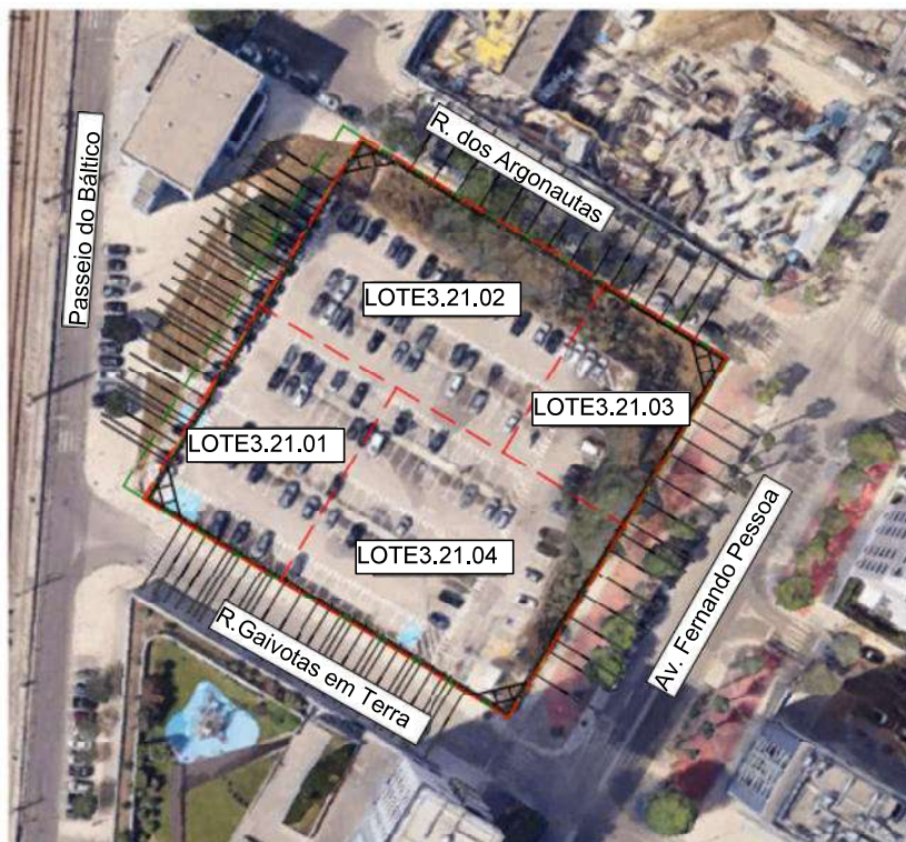
Figura 1 - Vista aérea do lote intervencionado (Google Maps)
