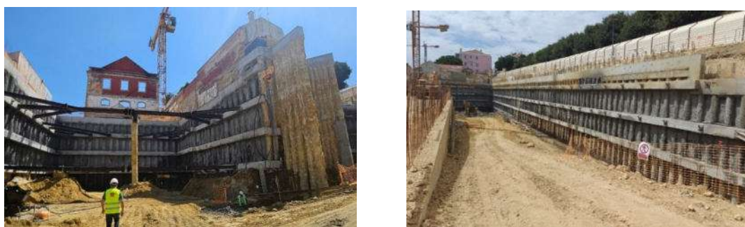
Figura 19 - Vista do Fundo de Escavação em Fase Final de Escavação
